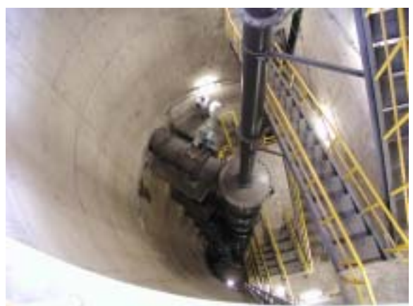
ます淵ダム (小倉南区頂吉) えん堤取水口内部
