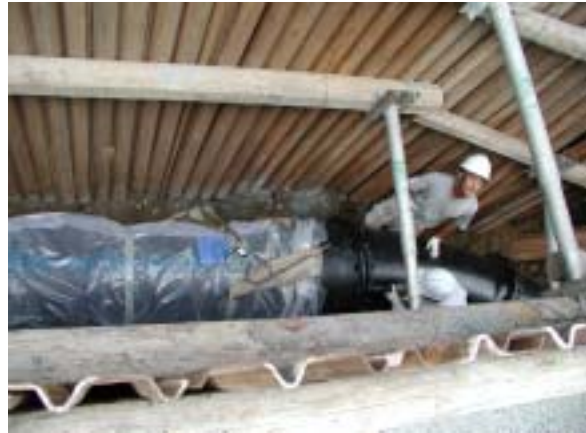
700mm ダクティル鑄鉄管布設状況
