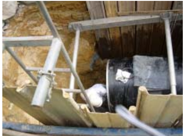
1100mm 鋼管布設状況
