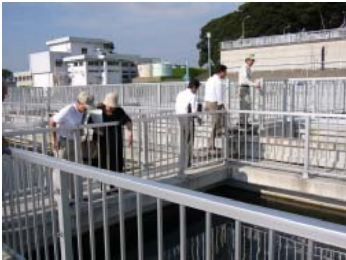
浄水場沈殿池
